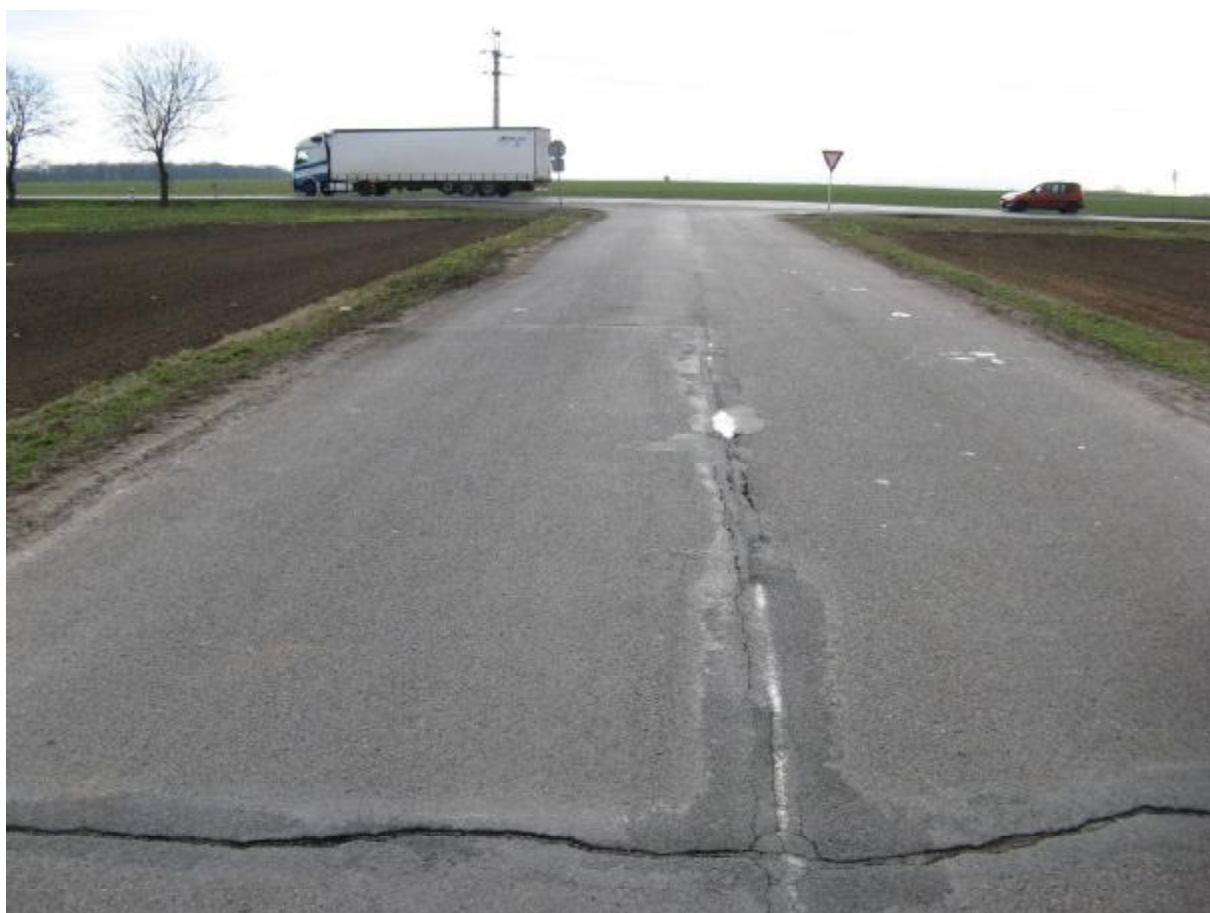
F21, km 0,910+ Podélné a příčné široké trhliny.
