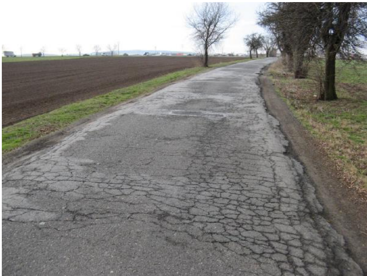
F14, km 0,610+ Síťové trhliny a olamování okrajů vozovky.
