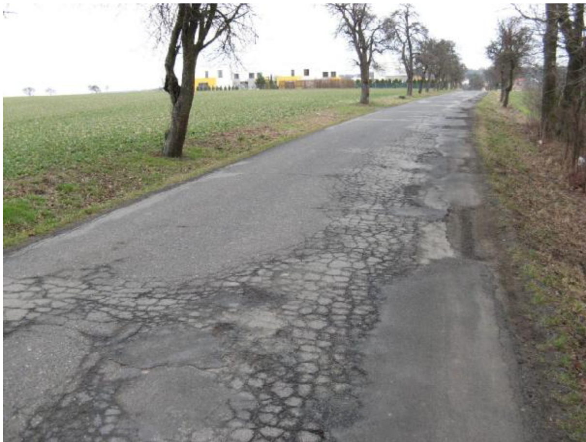
F10B, km 0,450- Síťové trhliny.
