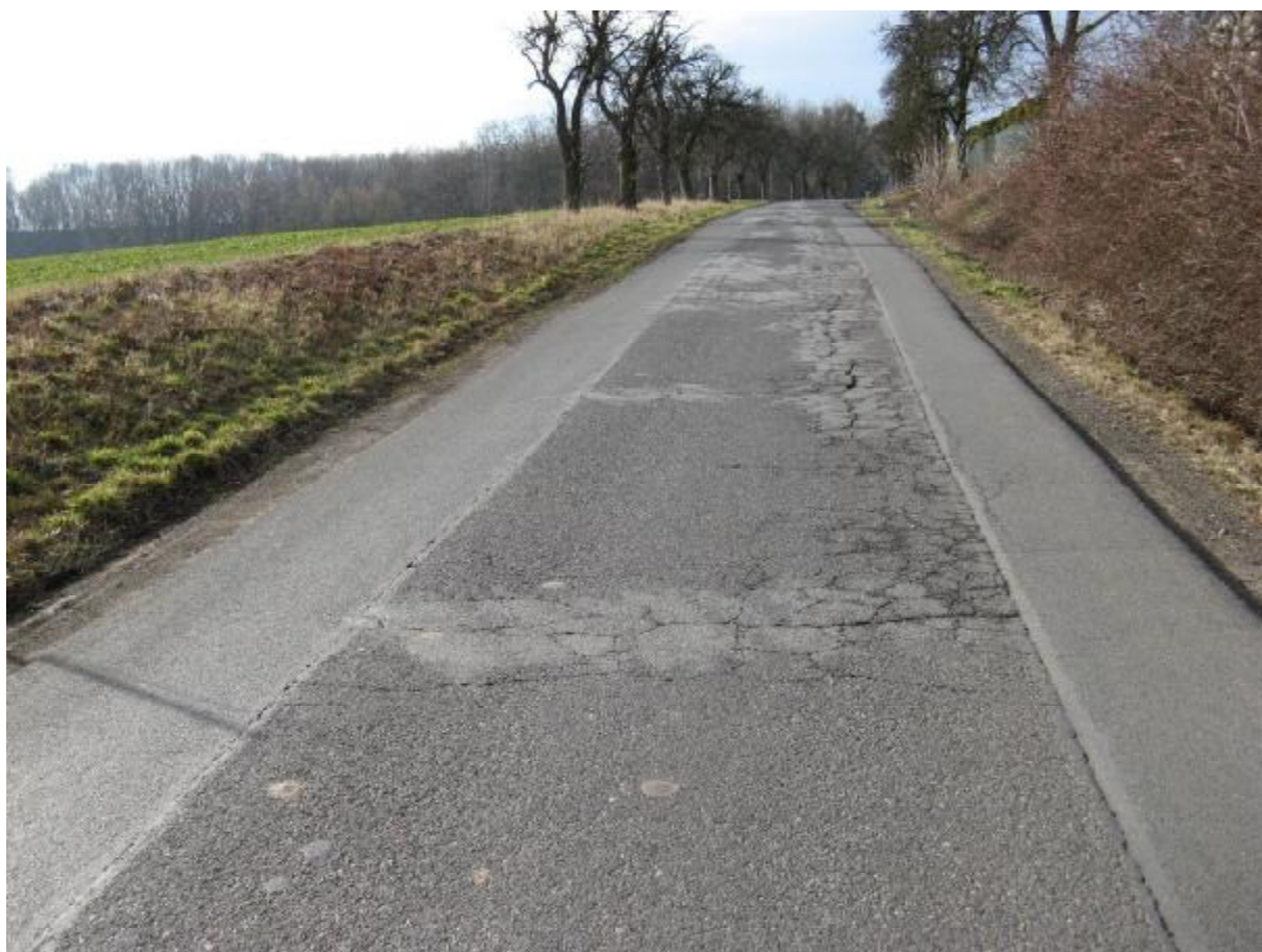
F05, km 0,210+ Sítňové trhliny, vysprávkování obou olámaných okrajů.
