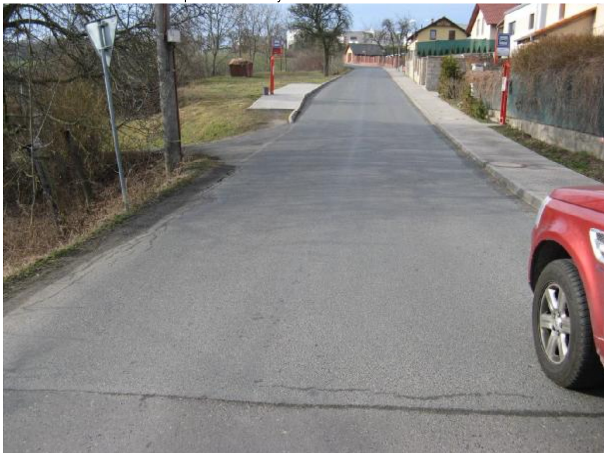
F02, km 0,015+ Pracovní spára a trhlina příčná, olamování okraje vozovky.
