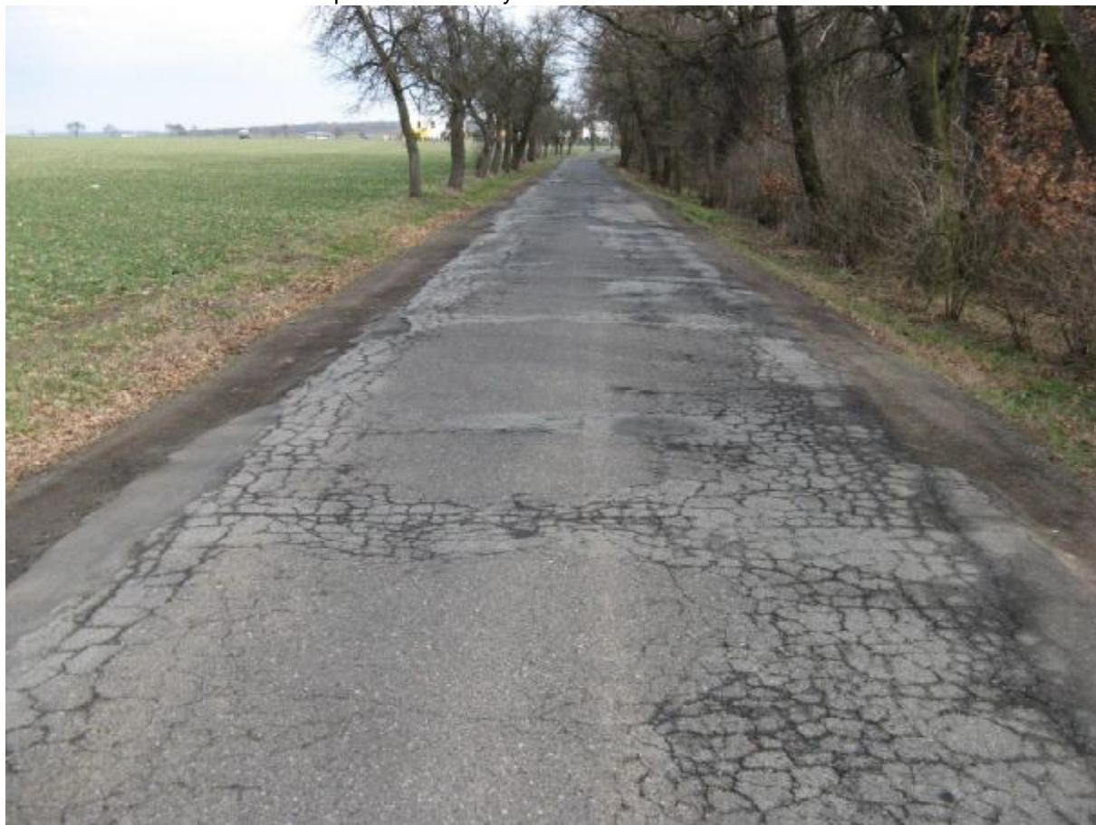
F13, km 0,600- Síťové trhliny a olamování okrajů vozovky.
