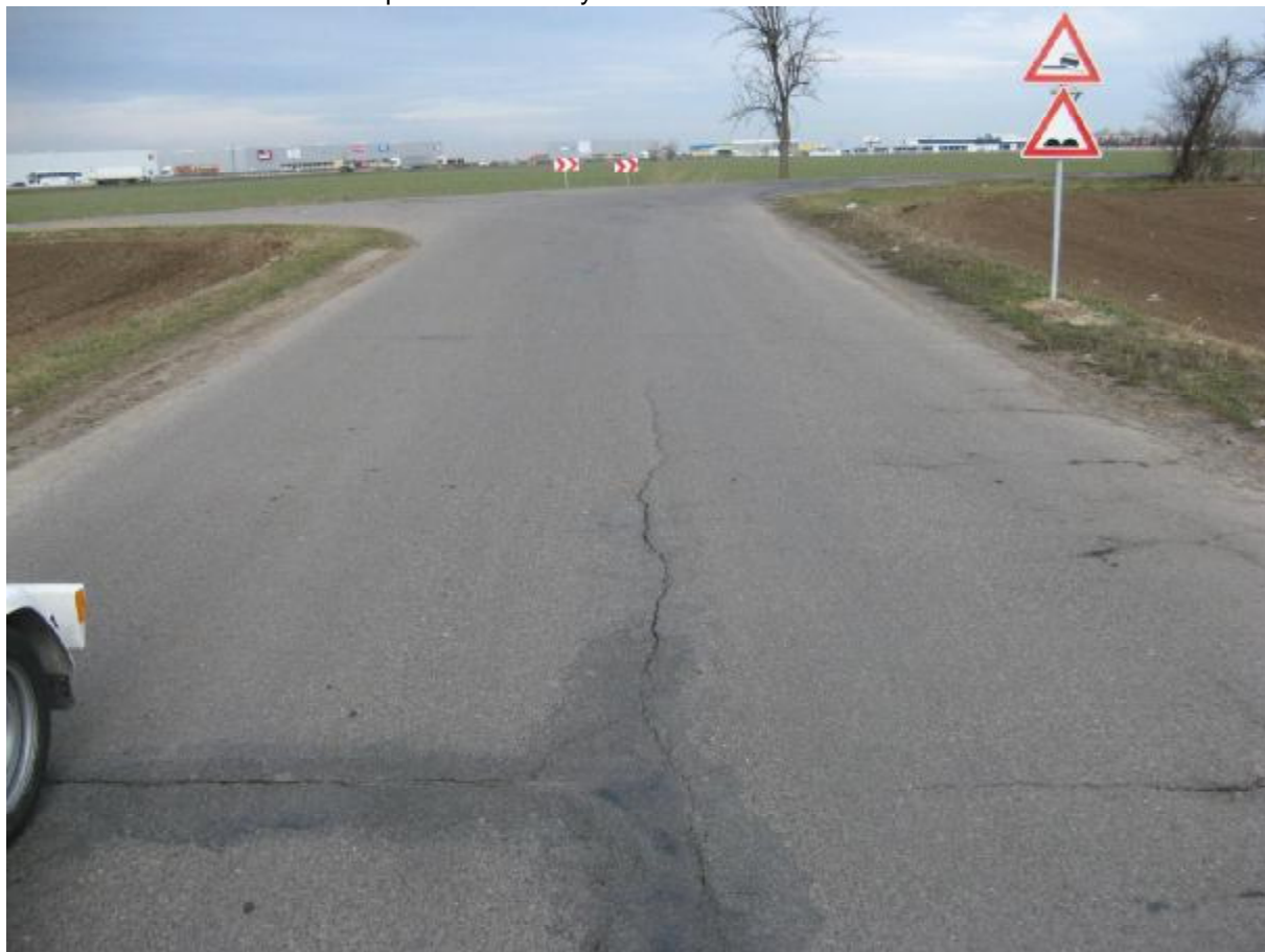
F20, km 0,900- Podélné a příčné široké trhliny.
